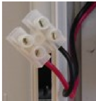
Рисунок 10. Кабель для подключения замка к блоку питания
